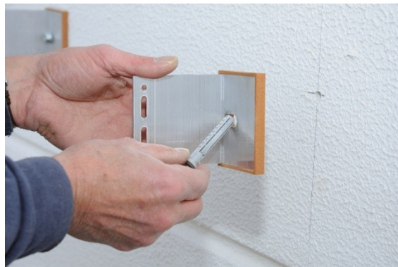
Upevnění distančního držáku a hmoždinky
