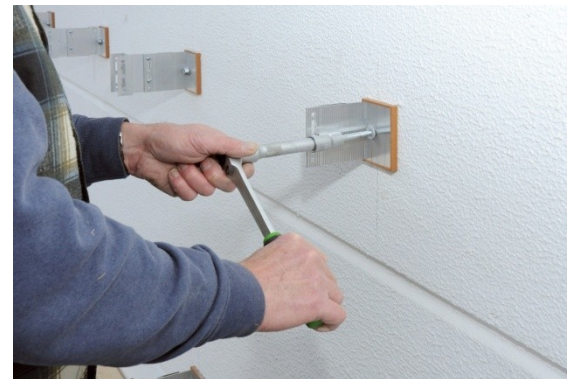
Přišroubování distančního držáku
