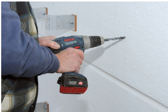
Vyvrátání otvoru pro hmoždinku
